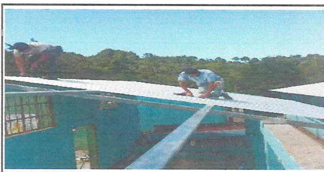
Foto 6: Sustitución de lámina por lámina troquelada
