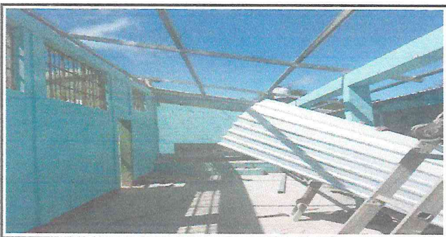
Foto 5: Sustitución de lámina por lámina troquelada
