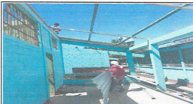
Foto 4: Sustitución de lámina por lámina troquelada
