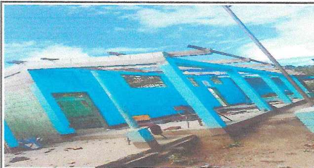
Foto 3: Sustitución de madera por metal
